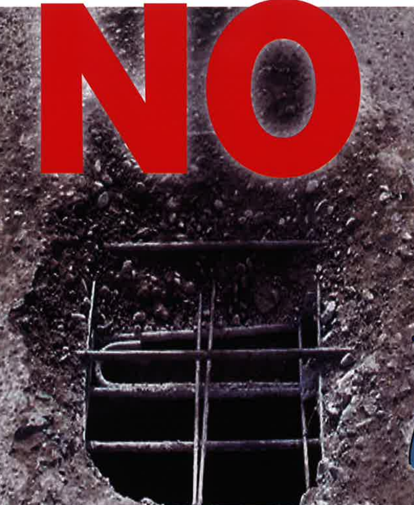
※写真は、橋梁のコンクリート床版の損傷事例
